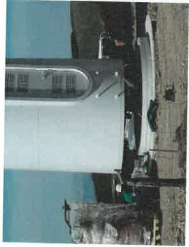
Assemblage des tronçons de mât
