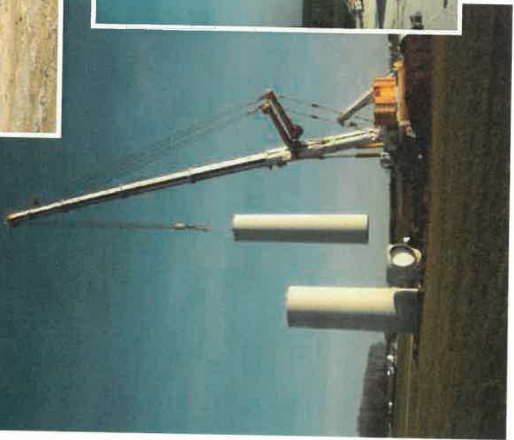
Assemblage des tronçons de mât
