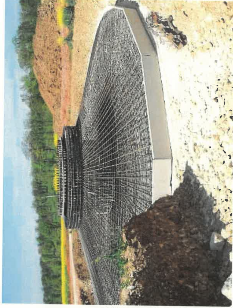
Cage d'ancrage servant de virole
