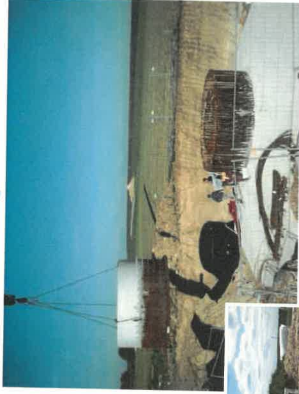
Coulage du béton de virole : 40 à 60 m 3
