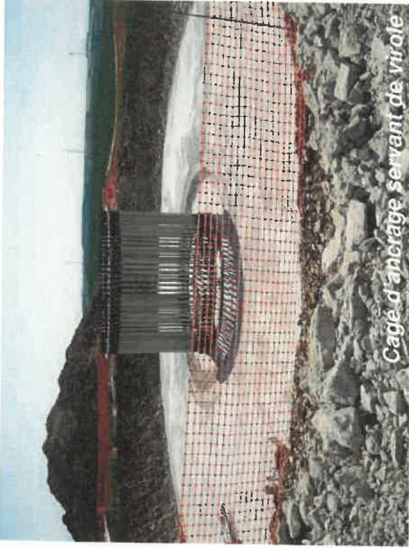
Début du ferrailage autour de la cage d'ancrage
