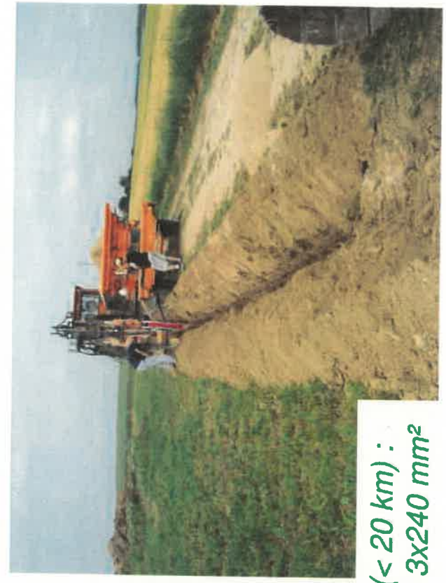
Enfouissement câbles : 0,5 à 1 m de profondeur
